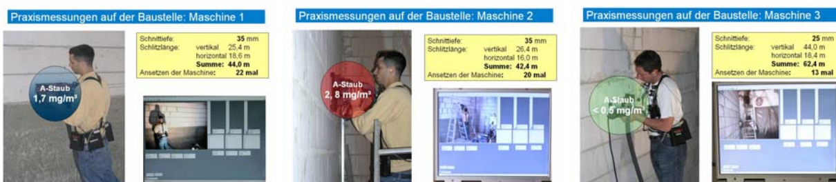
Abb. 7.2 – 2 Mauernutfräsen bei den Praxismessungen
