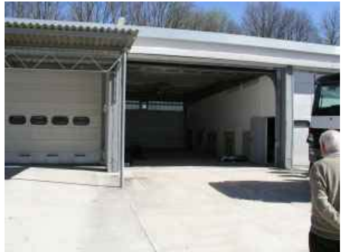
Abb. 5.3 - 1 Werkhalle 17 vor dem Umbau zum Prüfraum
